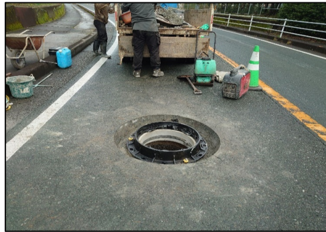
新設受枠設置
