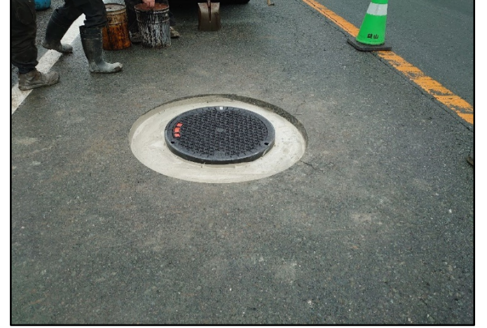
マンホール蓋固定完了
