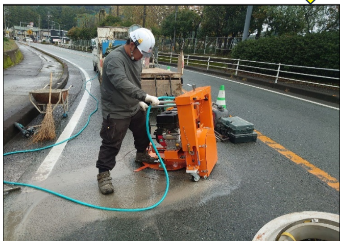
舗装版円形切断
