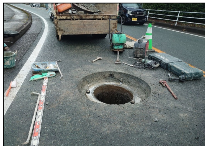
既設受枠撤去
