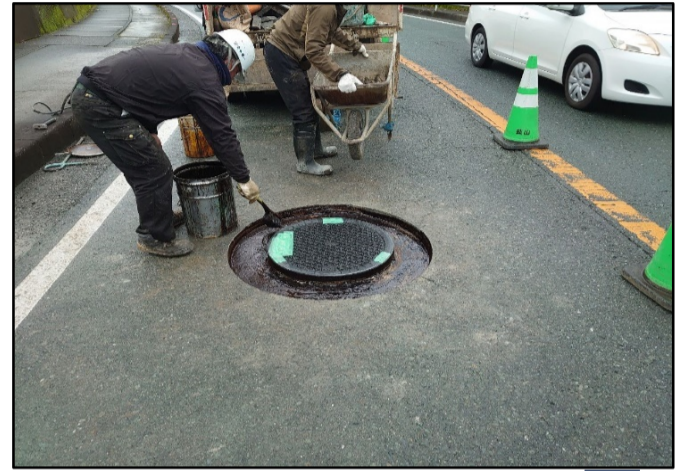
プライマー塗布
