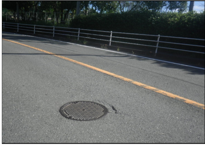
着工前（取替前）
