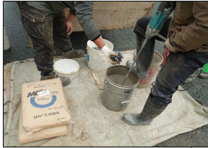
無収縮モルタル攪拌
